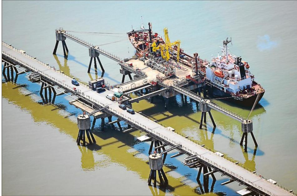
Der Anleger von Ineos im Jadebusen. Über diese Löschrücke wird unter anderem der Rohstoff für die PVC-Produktion, EDC, angeliefert. Der Name Ineos wird bald verschwin-
