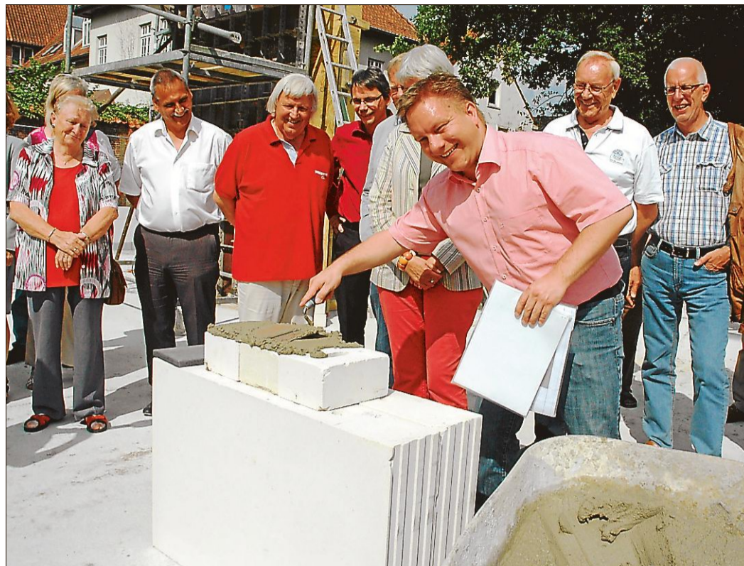
Bürgermeister Jan Edo Albers schwingt die Maurerkelle bei der Grundsteinlegung, Gäste aus Rat, Verwaltung und der beteiligten Firmen schauen zu.
